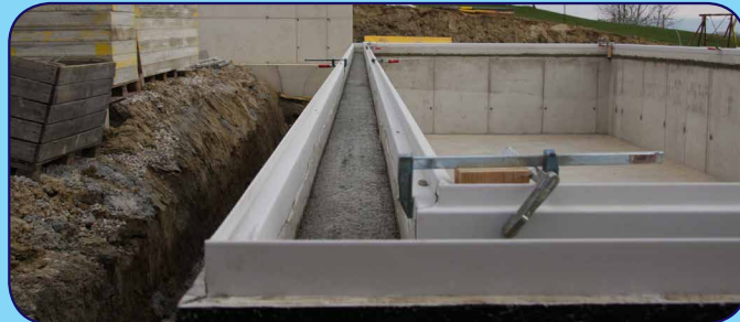
Ausgiessen der Rinne mit Gefälle zum Tank
