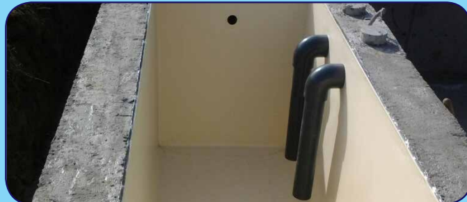
Folie und Verrohrung im Ausgleichstank
