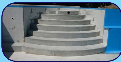
Vorbereitung der Treppe
