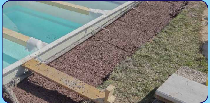
Hinterfüllung mit Spezial-Isolation
