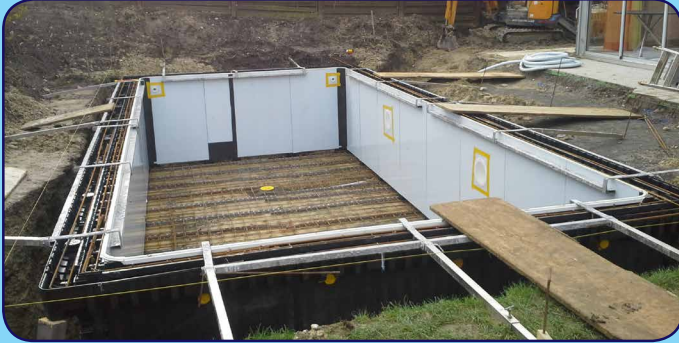
Erstellt mit vorgefertigten, armierten Wandelementen
