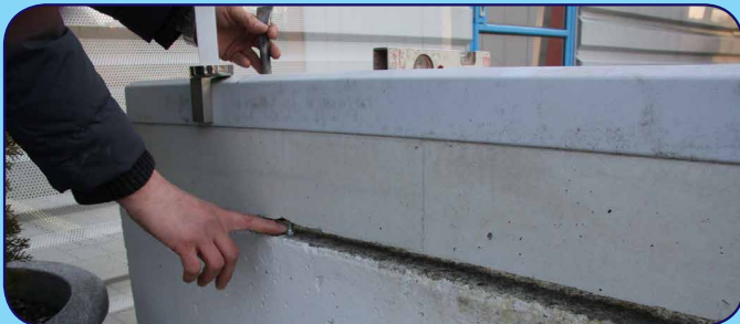
Rinne setzen und mit den Schrauben einnivellieren
