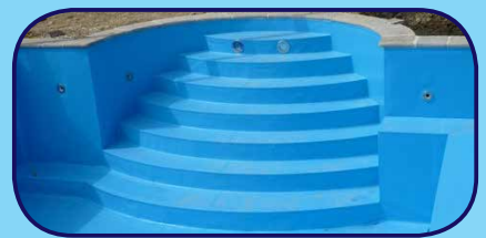
Folienauskleidung fertig verlegt
