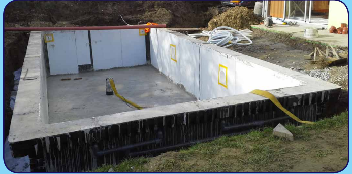
Fertig betoniertes Becken mit 30 cm Auflagerand
